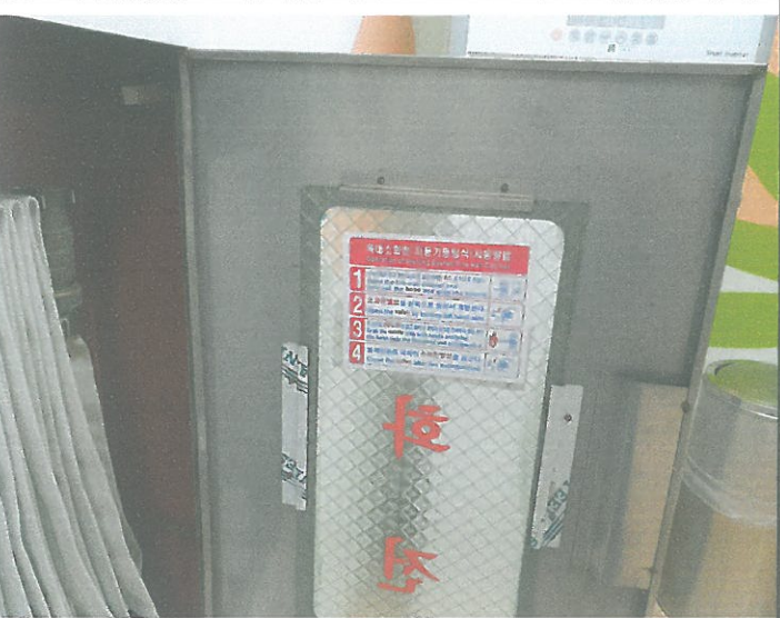
전층 옥내 소화전 문 내부 소화전 사용 설명서 부착 12개소
