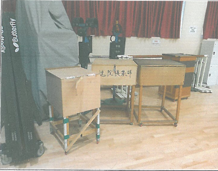
대체육관 배드민트 볼 보관함 파손 수리
