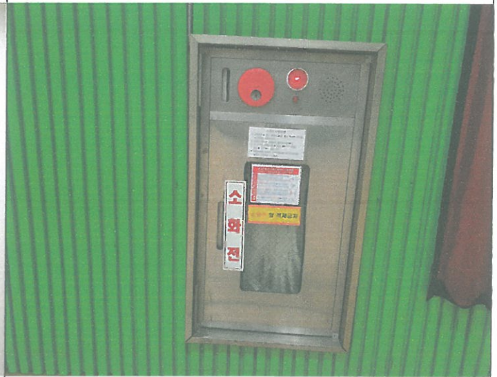
대체육관 외벽쪽 소화전 호수함 유리 파손개소 타이프 처리
