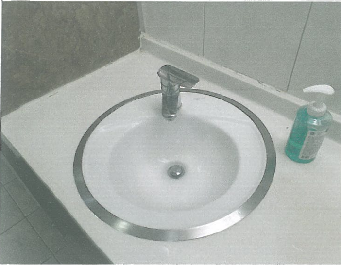
1층 남자 화장실 세면대 수전 교정
