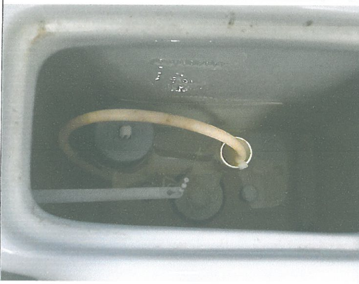
수영장 여자 샤워실 내 변기 후두바킹 교체
