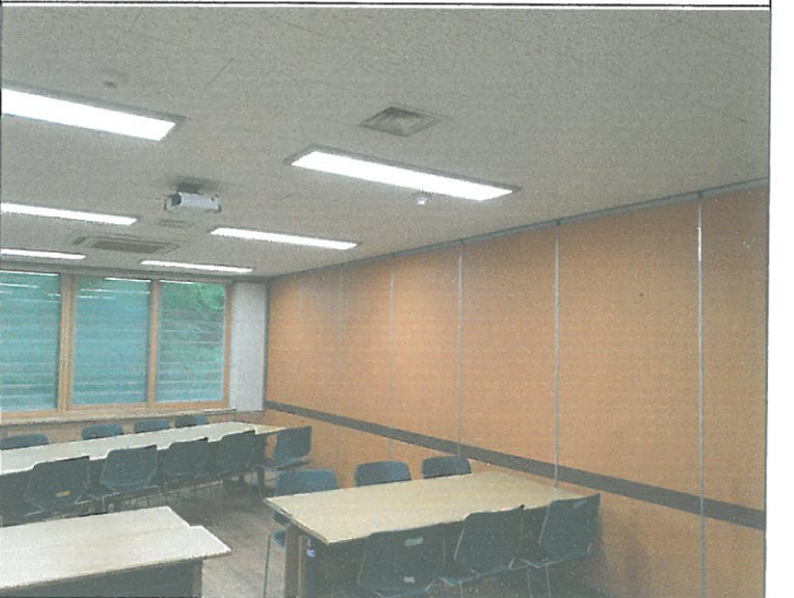
3층 진로1실. 2층 물품 창고 천장 오염 텍스 교체
