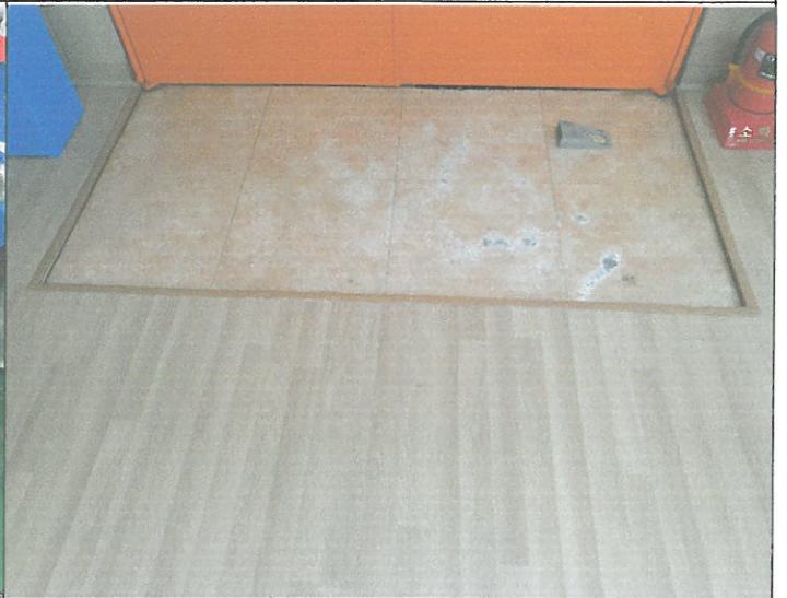
3층 소체육관 바닥 몰딩 탈거 되어 제 부착
