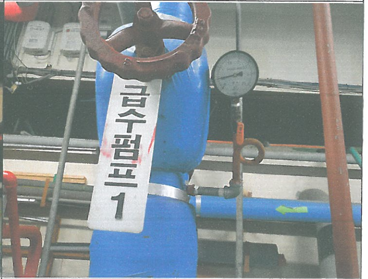
기계실 옥상 시수펌프 배관 압력싸이폰관 닛볼 엘보교체
