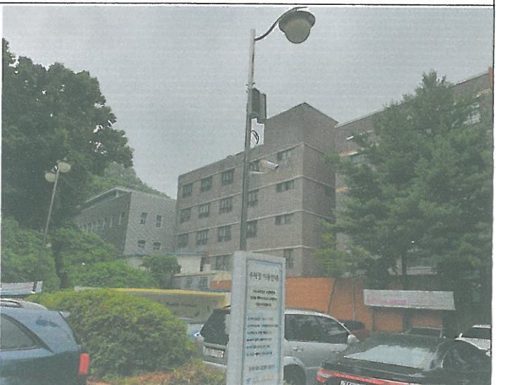
CCTV14번 카메라 케이블 제결선
