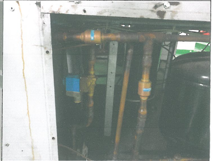
수영장 공조2호기 가스배관 솔레노이드 밸브 교체
