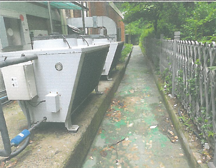
수영장 공조 냉방 실외기 방열핀 이물질 제거
