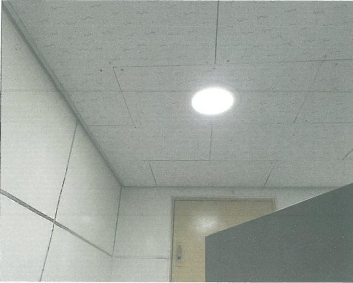
지하1층 남자 화장실 천장등 1개소 교체
