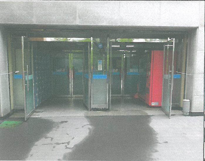
대체육관 앞 자판기 방풍실 강화문 열림거리 3개소 설치
