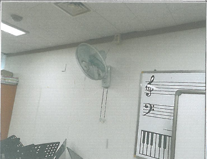
3층 아마데우스 실 선풍기 고장 교체
