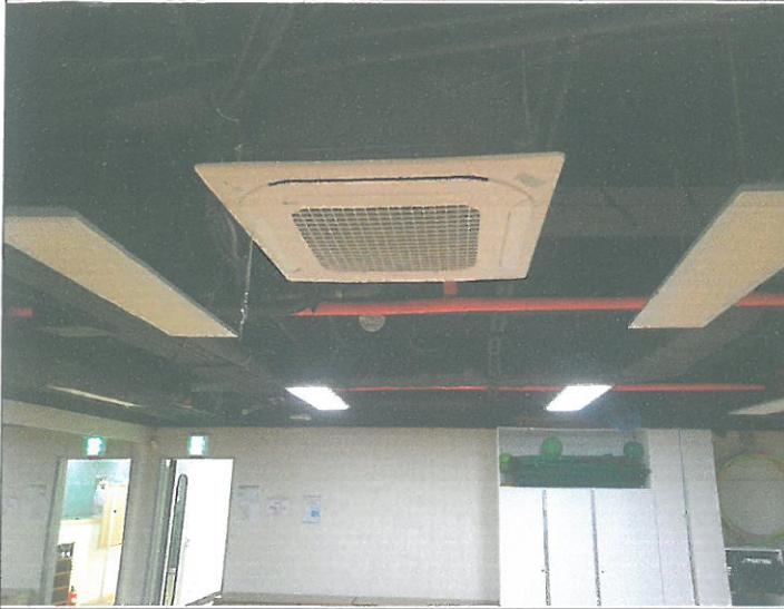
지하1층 소체육관 천장형 에어컨 필터 청소
