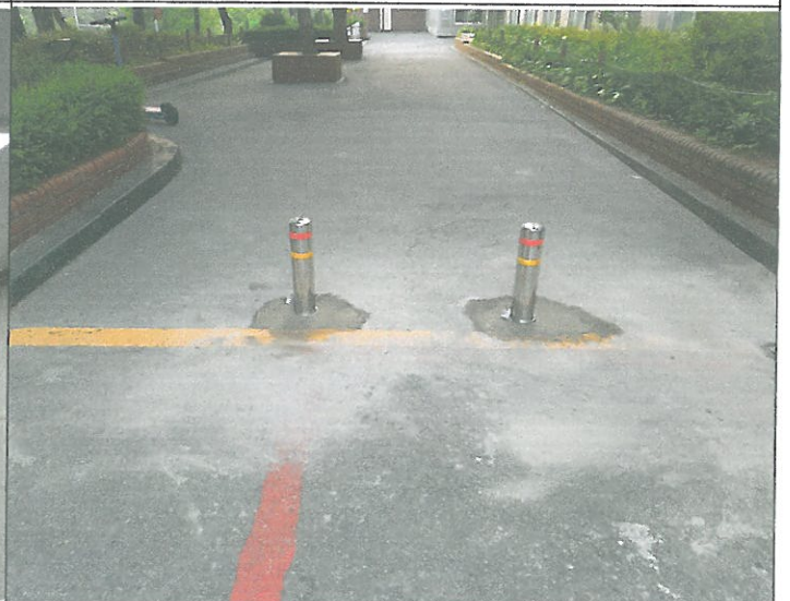
1층 주 출입구 진입로 블라드 설치
