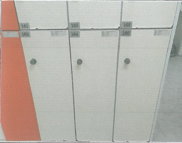
수영장 여자 탈의실 락카 문 경접 탈거 되어 제부착
